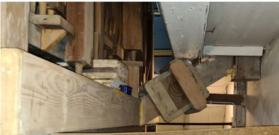
Blick auf eine in Zweitverwendung verbaute Balgfalte einer früheren Keilbalganlage
