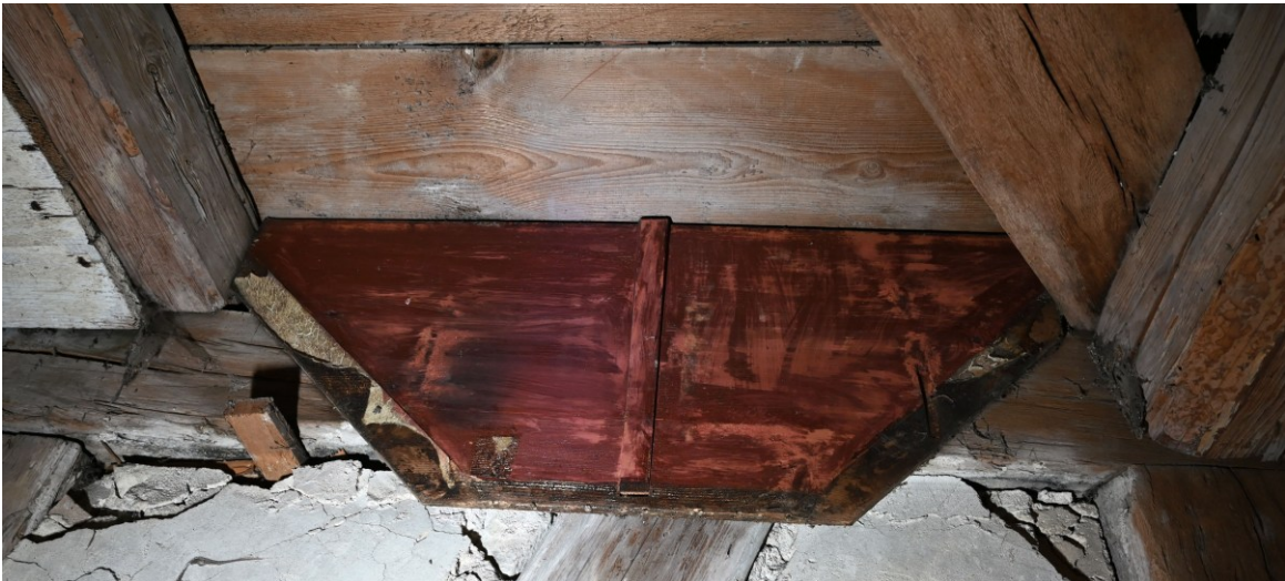
Blick auf eine in Zweitverwendung verbaute Balgfalte einer früheren Keilbalganlage
