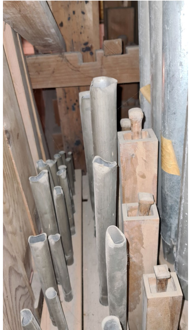
Blick auf die stark restaurierungsbedürftigen Mündungen des Metallpfeifenwerkes
