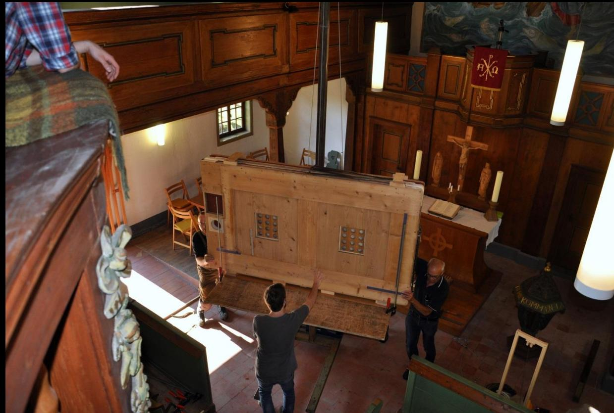
Einbau des Blasebalges und Versetzen nach rechts, um den Zugang zum Dachboden gefahrlos zu gewährleisten.
